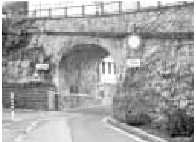
Der Tunnel zwischen Pizzeria Schloss Enn und Feuerwehrrhalle wurde vor genau 150 Jahren durchgeschlagen.
