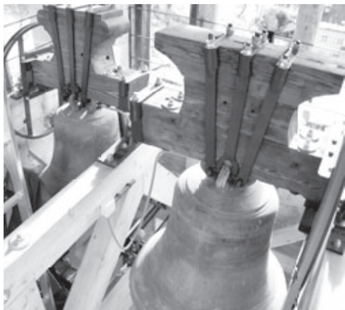
Die „Große“ (l.) und die „Elferin“ (r.). Bei allen Glocken wurden die Jöcher neu gefasst, die Klöppel neu gebunden, Klöppelfänger eingebaut und die Elektroinstallation erneuert.
