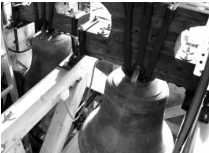
Die „Große“ (l.) und die „Elferin“ (r.). Bei allen Glocken wurden die Jöcher neu gefasst, die Klöppel neu gebunden, Klöppelfänger eingebaut und die Elektroinstallation erneuert.
