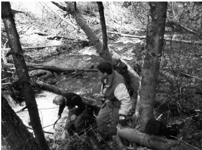
Baumstämme und anderes Gehölz wurden bei der Säuberung aus dem Bachbett entfernt, damit wird den Fischen weiterhin ein Durchkommen ermöglicht.
