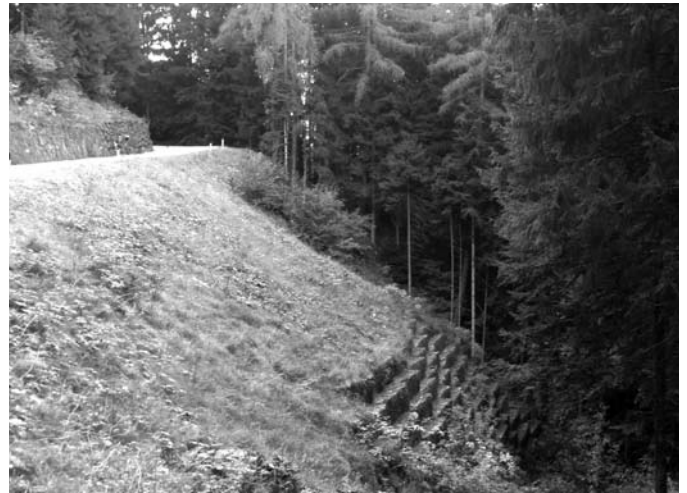
Mit der Anbringung von Leitplanken könnte die Verkehrssicherheit der Gschnoner Straße erhöht werden
