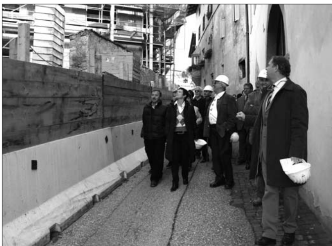
Arch. Zeno Bampi führte die interessierten Bürger durch und um den Rohbau „Pflege- und Altenheim Montan“
