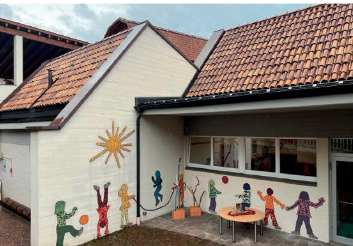
Der Kindergarten Montan soll energetisch saniert werden
