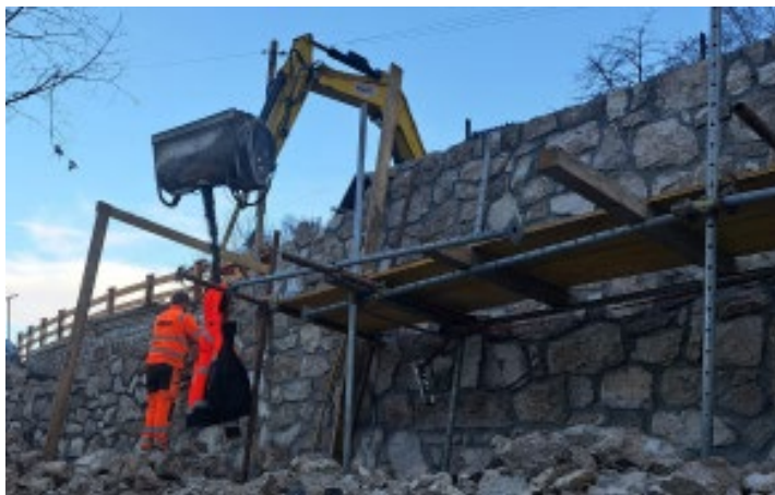
Reparatur der beschädigten Stützmauer in der Fraktion Glen – die Straße ist wieder sicher befahrbar
