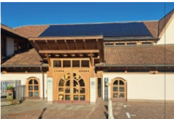
Teil der Fotovoltaikanlage auf dem Rathausdach
