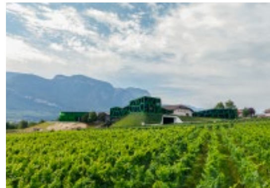
Die neue Produktionshalle schafft die Voraussetzungen für eine noch schonendere, flexiblere und präzisere Verarbeitung der Trauben – die Grundlage für höchste Weinqualität
